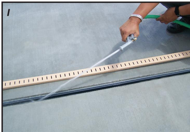
H, I. Las tapas superiores se pueden quitar fácilmente para limpiarlas o reemplazarlas. La tapa superior se abre y se abre mediante el fl exo de las patas de la tapa superior. Este accesorio único no tiene sujetadores externos (tornillos) que restan valor a la apariencia atractiva.
