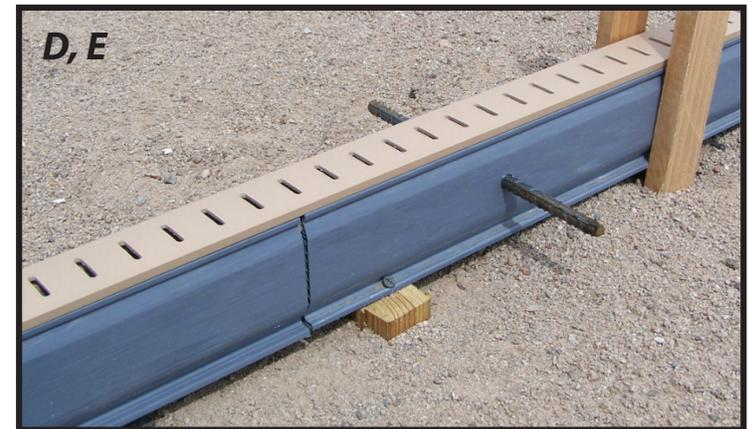
**D.** Instale la tapa superior, asegurándose de "traslapar" la parte superior más allá de las juntas para asegurar la rigidez. Agregue estacas adicionales a cada lado del drenaje para apoyar temporalmente el drenaje durante el vertido.
