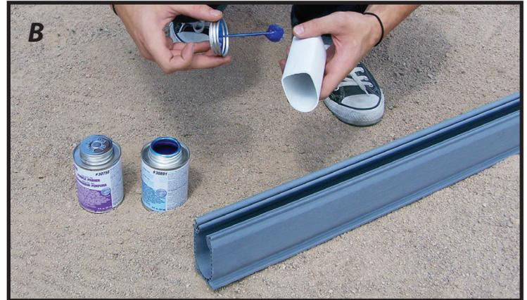
**B.** Usando P.V.C. imprimación y cemento tanto en el drenaje como en los coples, pegelos en una sola pieza.
