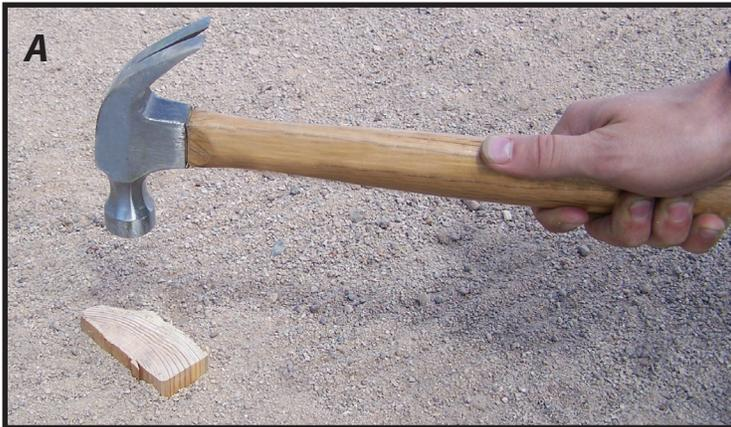
**A.** Con una cuerda, coloque estacas de 3 pulgadas a lo largo del camino del drenaje cada 30 pulgadas.
