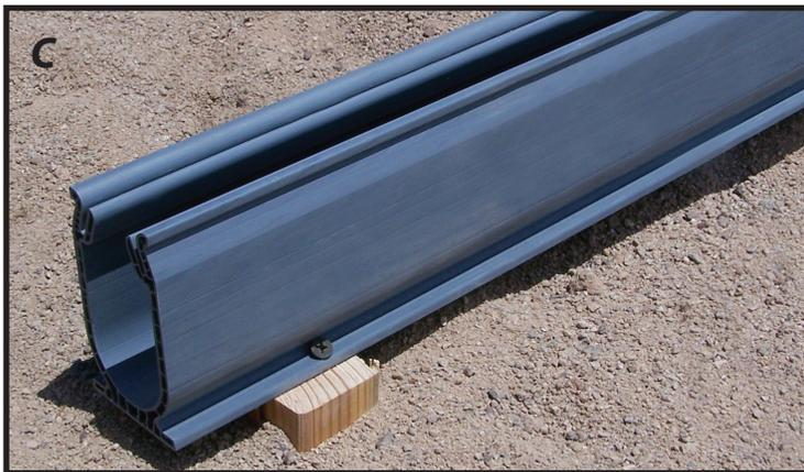
**C.** Con clavos o tornillos para placas de roca, fije el drenaje a las estacas de 3 pulgadas que se han colocado a nivel.
